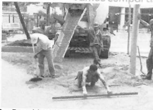
Figura 8 – Recebimento e espalhamento do concreto.
