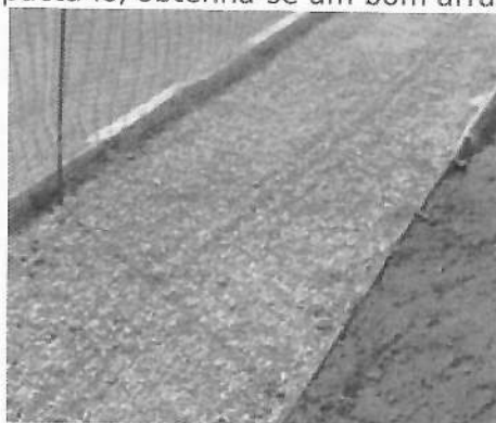
Figura 7 – Espalhamento da camada de Brita
